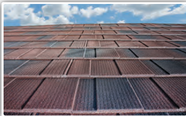
Obr. 11/2: Kotviace prvky - nastreľovacie klinec vôbec nevidieť.
