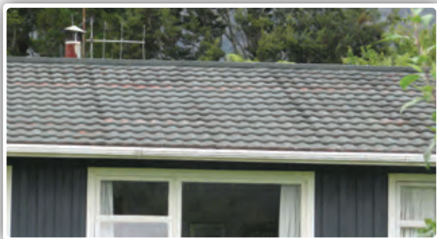
Obr. 16/2: Oceľová krytina s kamenným granulátom po 40 tich rokoch - Jackson Bay, Nový Zéland.
