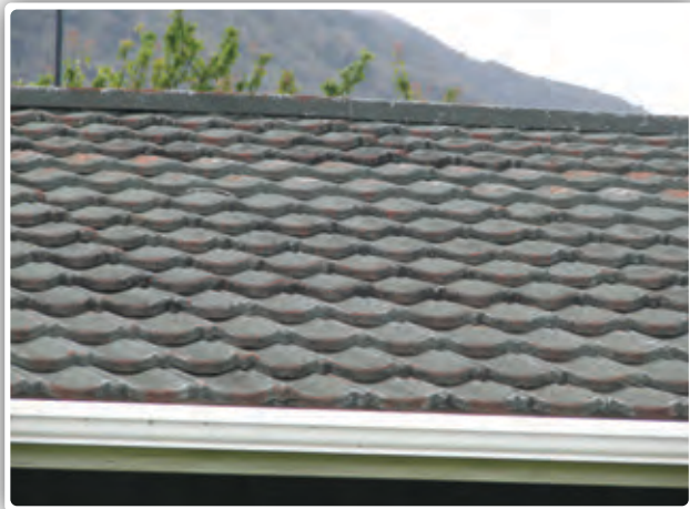
Obr. 16/3: Akrylátový náter aplikovaný ešte na pozinkovaný plech v r. 1973, teda na začiatku vývoja tejto krytiny - Jackson Bay, Nový Zéland. Za posledných 40 rokov sa však vyvinul tento akrylát ďaleko kvalitnejší a aplikuje sa už na kovový ochranný povlak - zliatinu zinku, hliníku a horčíku ZM.
