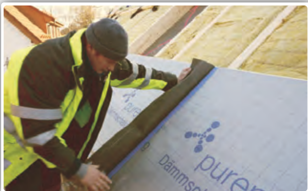
Obr.14/1: Spájanie PIR panelov
