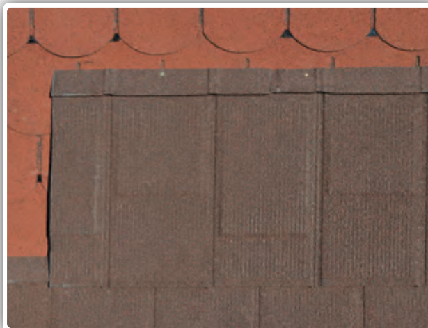
Obr. 12/3: Montáž krytiny mRock priamo na asfaltový šindel
