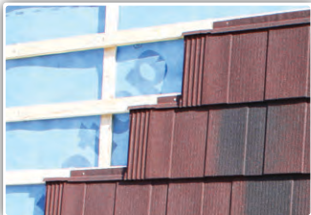
Obr. 11/1: Bežný spôsob montáže na vodorovné laty
