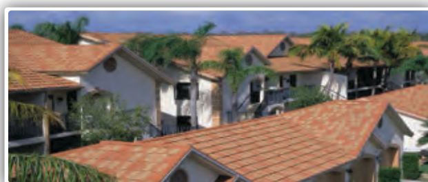
Obr. 16/3: Akrylátový náter aplikovaný ešte na pozinkovaný plech v r. 1973, teda na začiatku vývoja tejto krytiny - Jackson Bay, Nový Zéland. Za posledných 40 rokov sa však vyvinul tento akrylát ďaleko kvalitnejší a aplikuje sa už na kovový ochranný povlak - zliatinu zinku, hliníku a horčíku ZM.
