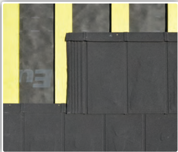
Obr. 13/1: Montáž krytiny mSlate bez vodorovného latovania a s odstráneným asfaltovým šindlom
